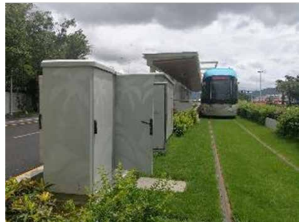
现场安装，中国三亚
